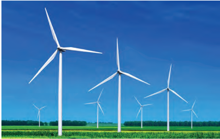
Figura 6. Turbina eólica [Fotografía digital]. Fuente: https://www.gettyimages.es/fotos/wind-turbine , s.f.
